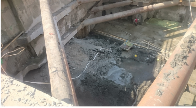
Рис. 2. Пригрузка в зоне смещения грунта в котлован
